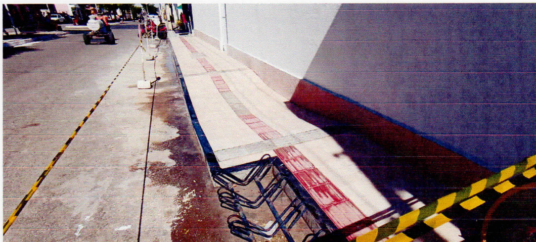
FOTO 06 – EXECUÇÃO DE CALÇADA COM PISÓ ANTIDERRAMENTE E SINALIZAÇÃO TÁTIL, COM RAMPA PADRAO DE ACESSIBILIDADE
