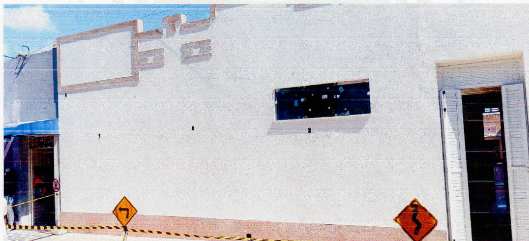
FOTO 07 – FECHAMENTOS DE VÃOS E REVITALIZAÇÃO DA FACHADA DA AVENIDA CAPITÃO JOSÉ NARCISO CO APLICAÇÃO DE REVESTIMENTO TIPO FULGET
