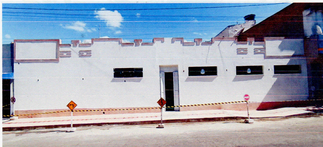
FOTO 07 – REVITALIZAÇÃO DA FACHADA DA AVENIDA CAPITÃO JOSÉ NARCISO CO APLICAÇÃO DE REVESTIMENTO TIPO FULGET
