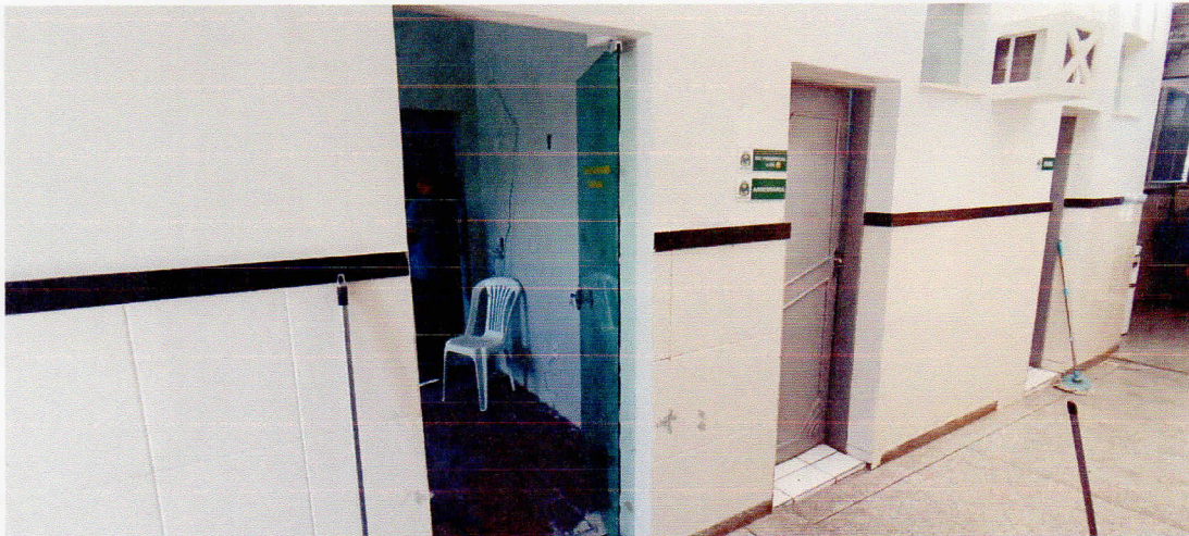
FOTO 03 – ABERTURA DE VÃO E ASSENTAMENTO DE ESQUADRIA DE VIDRO
