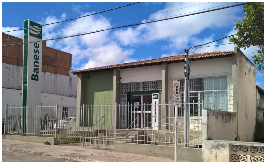
Figura 18 Fotografia da Agência Banco do Estado de Sergipe (Banese) em Poço Verde Fonte: Tiago Santana (2015)
