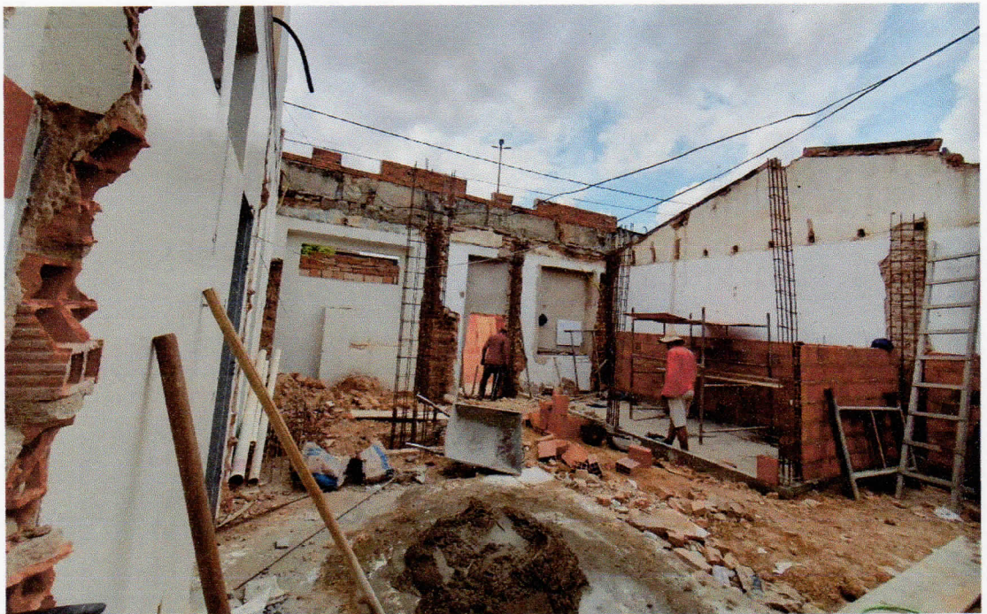
Imagem das demolições internas
